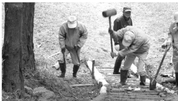
階段側面の土留め(炭焼き広場)
